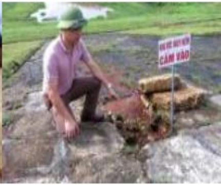
Thảm đập chính hồ Núi Cốc, tỉnh Thái Nguyên
