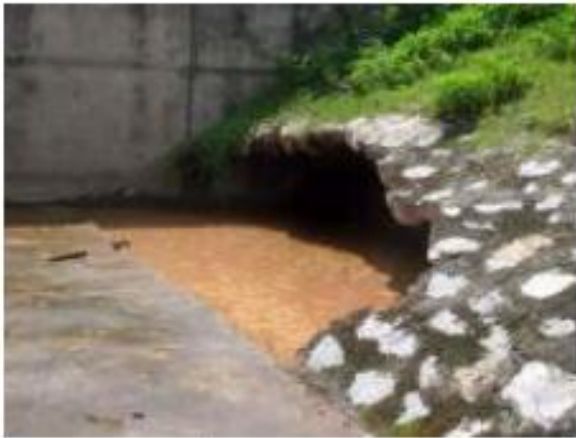
Xói ngầm gây sụt lún ở công Tắc Giang, tỉnh Hà Nam
