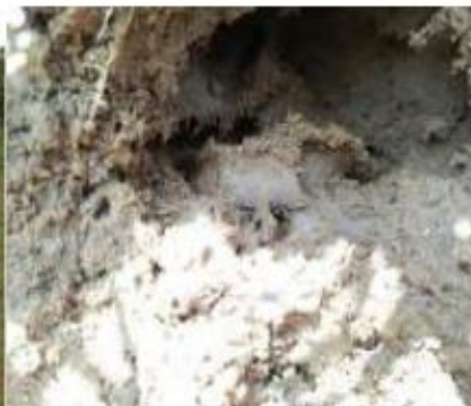
Tổ mối trong thân gây sụt lún đê tả sông Cầu, tỉnh Bắc Giang
