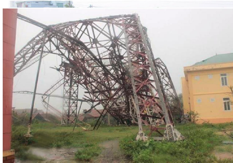
Tháp Kỳ anh Hà tĩnh (XD 2011) cao 100m bị đổ gục trong bão số 10 Cấp 14-15 ngày 15/9/2017
