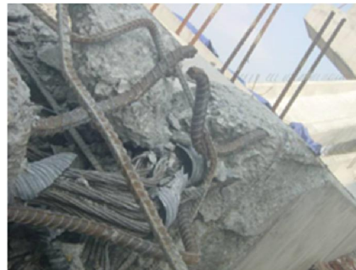
Hiện tượng rỉ vữa trong ống ở một số dầm cầu được dỡ ra
