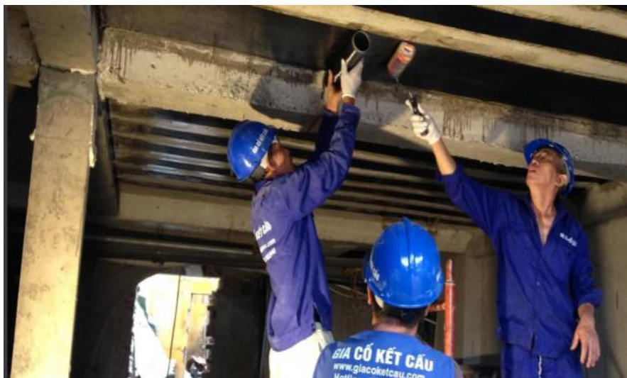
Gia cố dầm chống uốn
