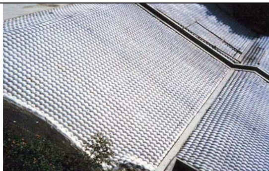
Bảo vệ bờ bằng thảm bê tông FS
