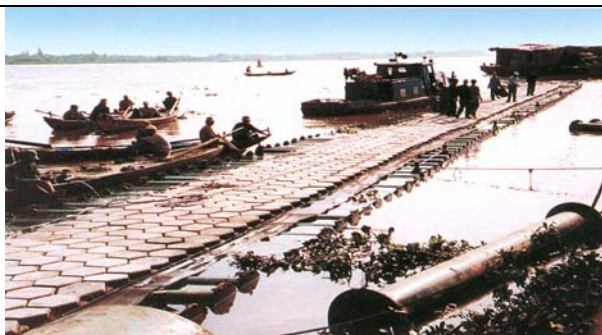
Thi công lắp ghép lưới thảm P.Đ.TAC-M
