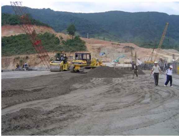
Hình 3. Rải, san và đầm bê tông trên mặt đập
