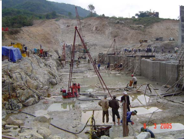
Hình 2. Khoan phụ xử lý nền đập
