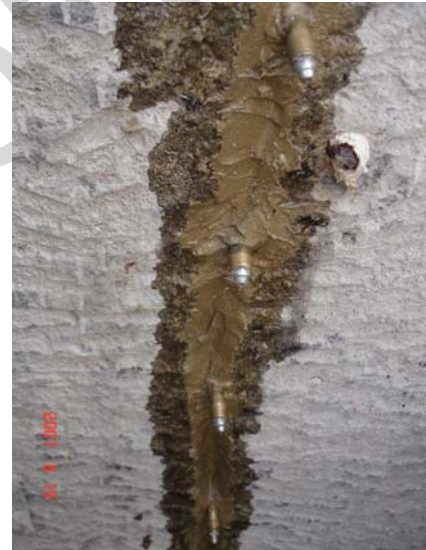
Hình 4. Đổ bê tông tường chống thấm và xử lý khe nứt co ngót bằng Sikadur
