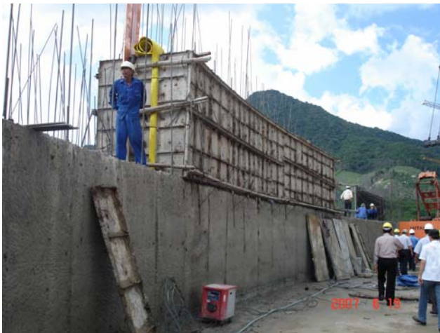
Hình 4. Đổ bê tông tường chống thấm và xử lý khe nứt co ngót bằng Sikadur
