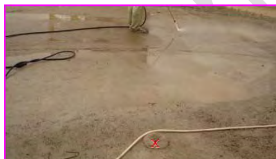
Hình 7: Tạo lỗ (x) để đo diễn biến nhiệt độ khối đổ
