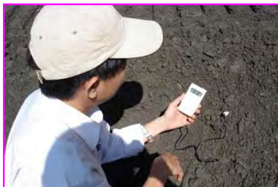
Hình 5: Đo nhiệt độ hỗn hợp vữa BTĐL tại khối đổ
