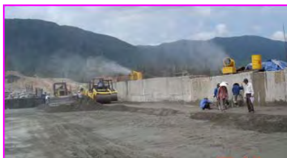
Hình 6: Sử dụng máy phun sương giữ ẩm, hạ nhiệt môi trường thi công
