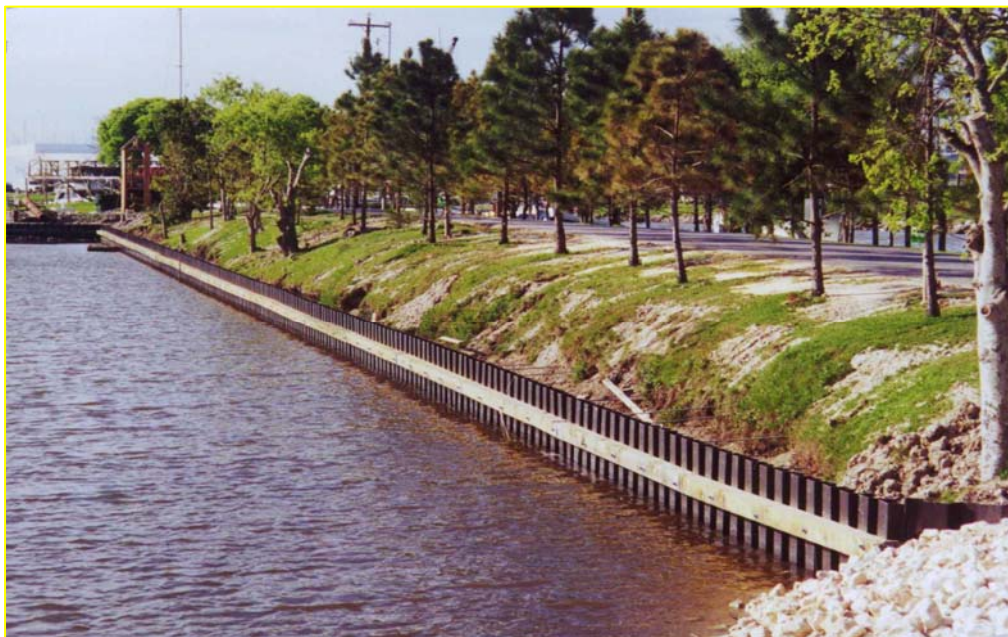
Tường cừ chắn đất làm bằng Composite
