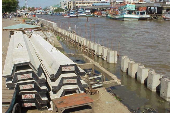
Thi công kè bảo vệ bờ bằng bê tông ứng suất trước tại Kiên Giang
