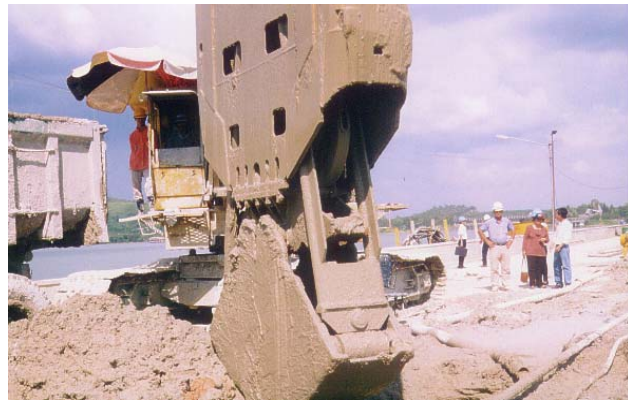
Thi công hào Bentonite chống thấm
