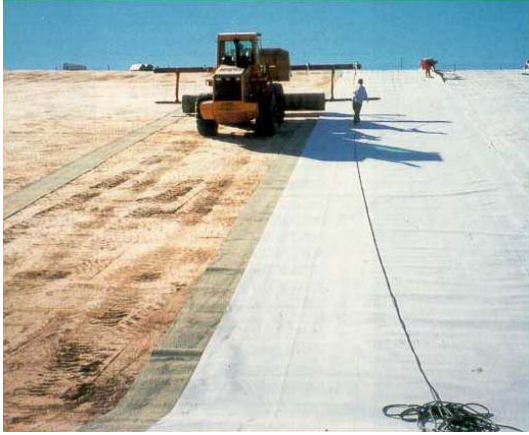
Thi công trải vải địa kỹ thuật
