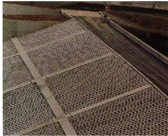
Bảo vệ bờ bằng thảm bê tông FS
