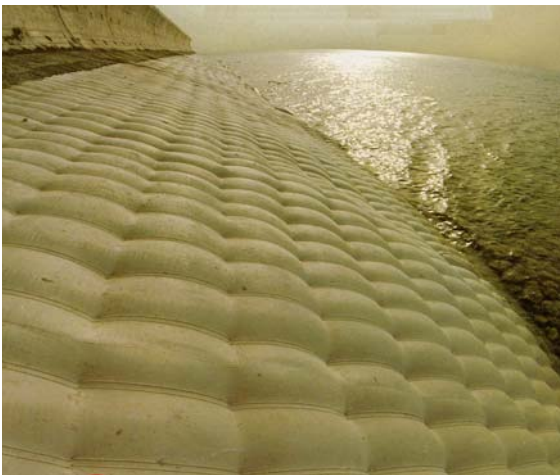
Bảo vệ bờ bằng thảm bê tông FS
