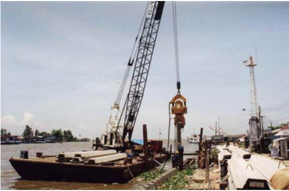
Thi công kè bảo vệ bờ bằng bê tông ứng suất trước tại Kiên Giang
