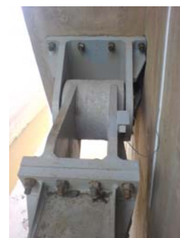
H3. Vị trí lắp đặt
