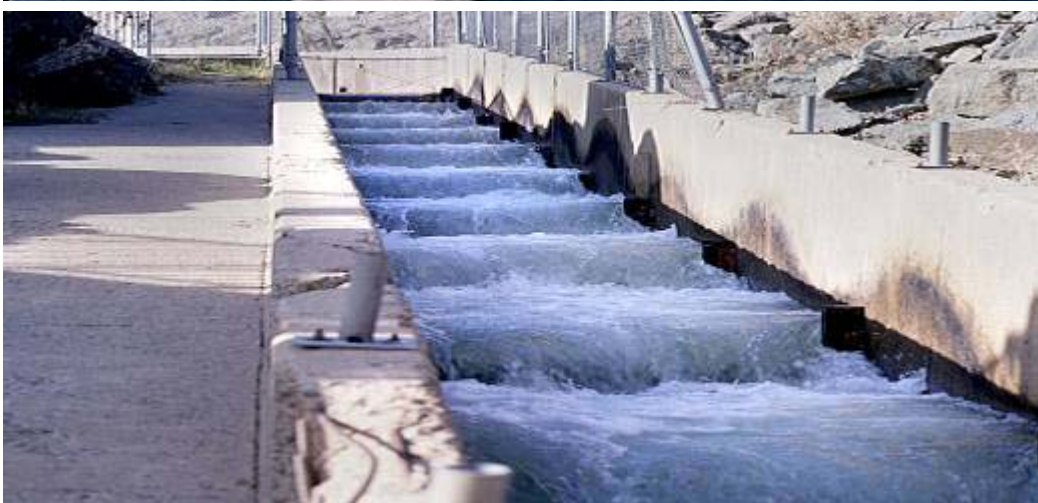
Một số hạng mục công trình trên tuyến cá bơi qua đập lên thượng lưu
