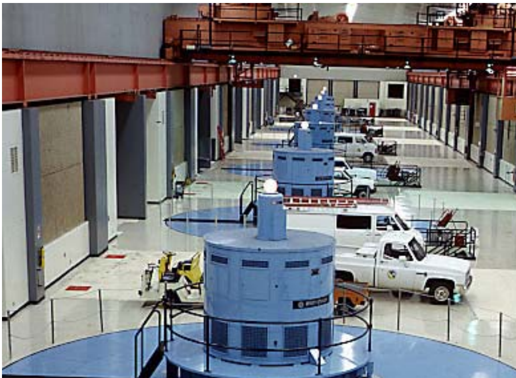
Bên trong nhà máy thủy điện Hyatt
