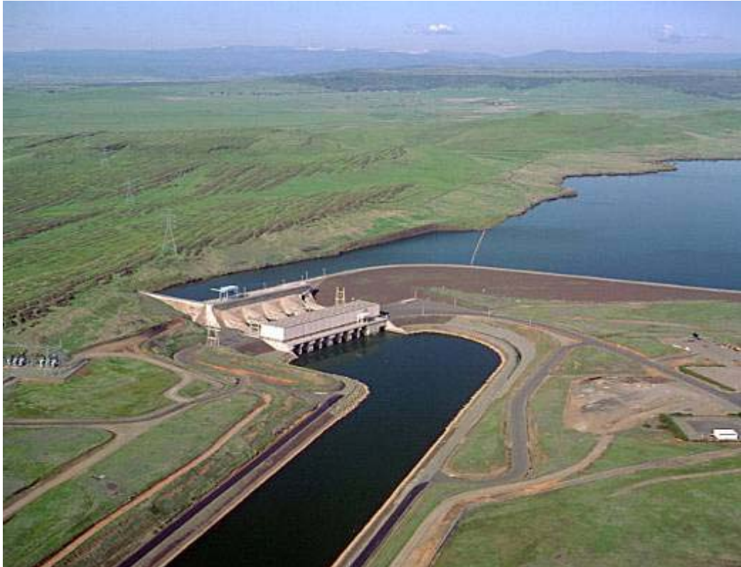
Nhà máy thủy điện Hyatt có kết hợp bơm tích năng
