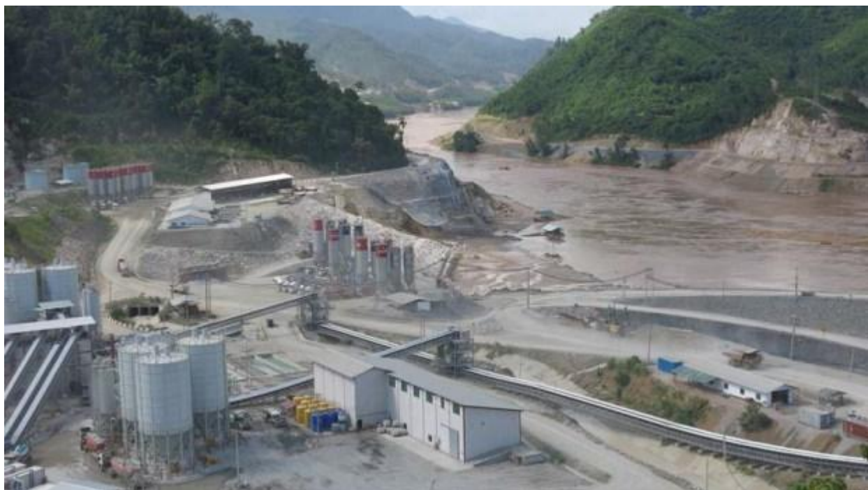
Hình IV: công trường xây đập Xayaburi 1,200 MW con đập dòng chính đầu tiên của Lào [nguồn: Tom Fawthrop]
