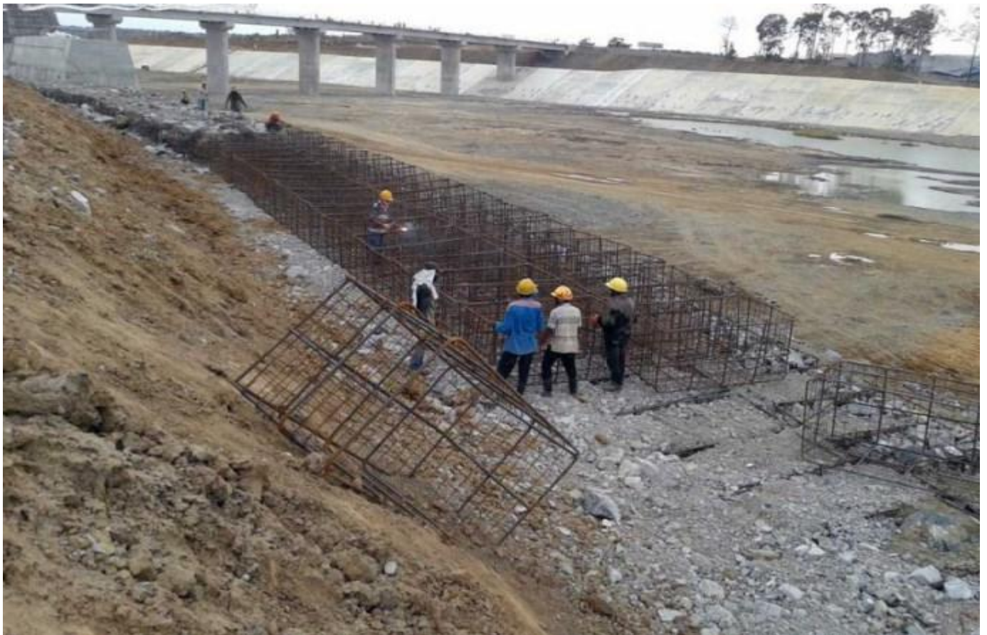
Hình IIIc: Công trường xây đập thủy điện Hạ Sesan 2 Stung Treng đông bắc Campuchia [nguồn: Phnom Penh Post, 12/2014]
