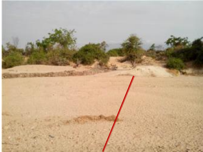
Đập cát do Trường ĐHTL thiết kế tại Ninh Thuận. Đưa vào sử dụng tháng 12/2015
