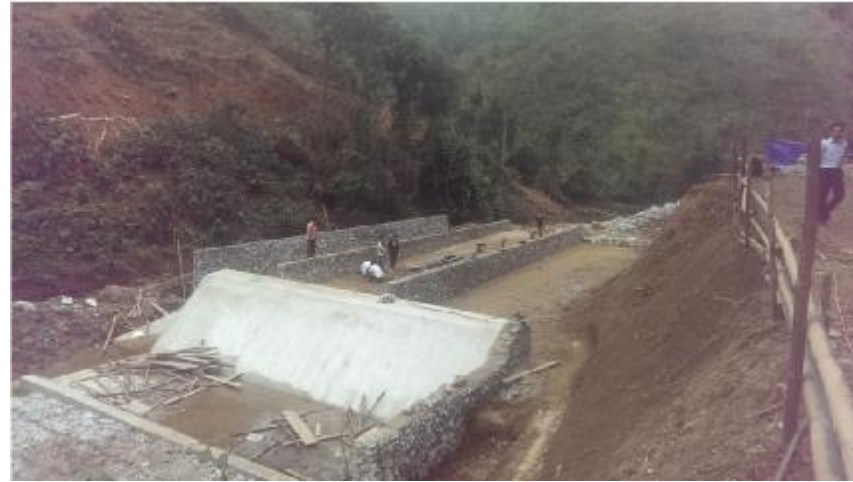
Đập ngầm xây dựng trong dự án ADB8, cấp cho 5000 người tại Kim Ngọc, Hà Giang năm 2016
