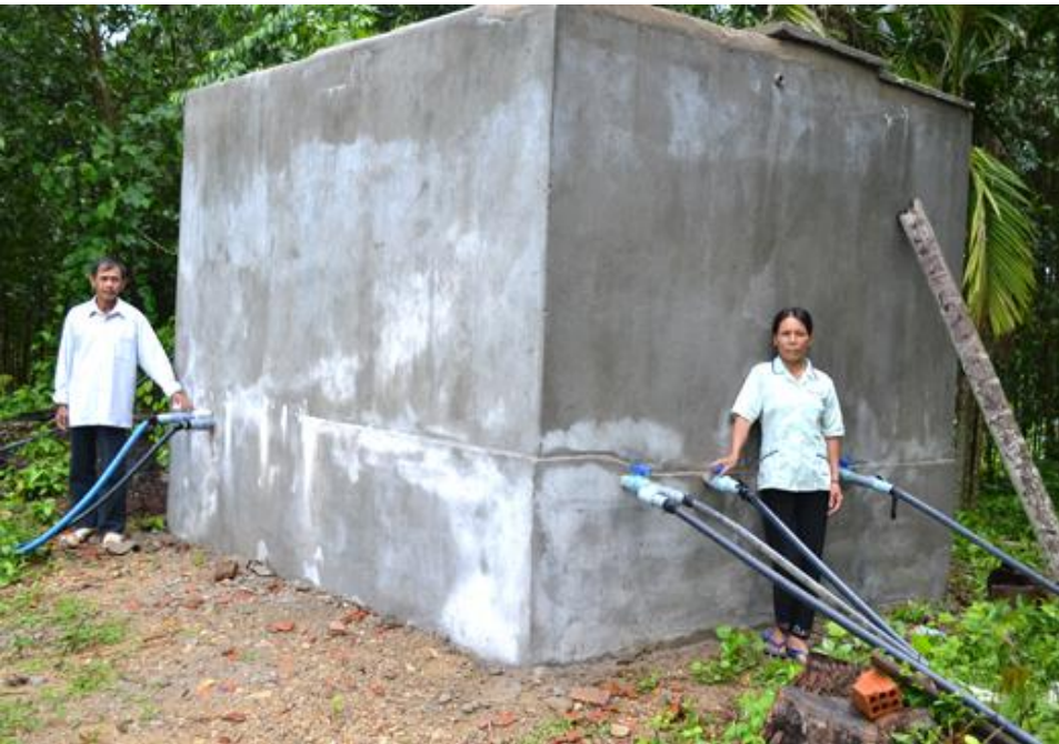
Hình 3.1: Bể chứa gạch xây
