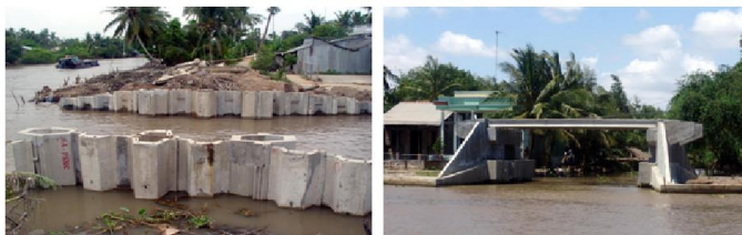
Hình 5: Thi công công Sấu Kim - Hậu Giang ( B_c=8m ) bằng công nghệ công lắp ghép bằng cừ BTCT dự ứng lực
