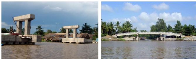
Hình 4: Thi công trụ pin và cầu giao thông công Ông Dèo - Hậu Giang ( B_c=15m )
