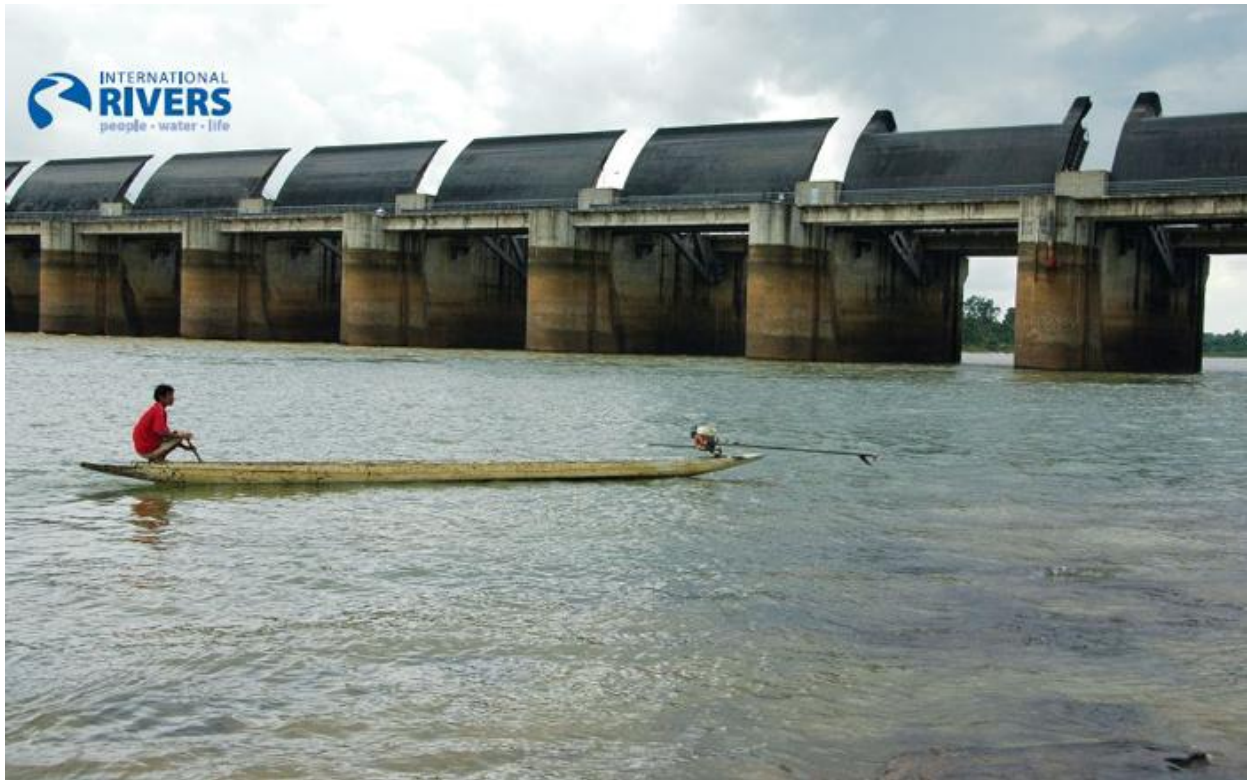
Đập thủy điện Pak Mun
