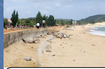
Sạt lở KV bờ biển Tam Quan, Bình Định Chiều dài khoảng 5,6km Gây ảnh hưởng tới hoạt động tàu thuyền, làm mất đất sản xuất cư dân ven biển và nguy cơ mất bãi biển du lịch
