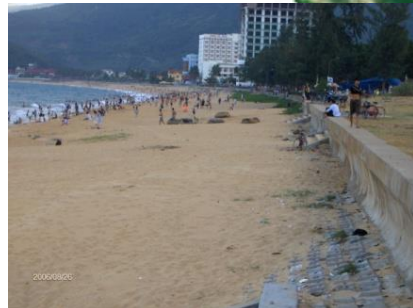
Công trình bảo vệ bờ biển thành phố Quy Nhơn
