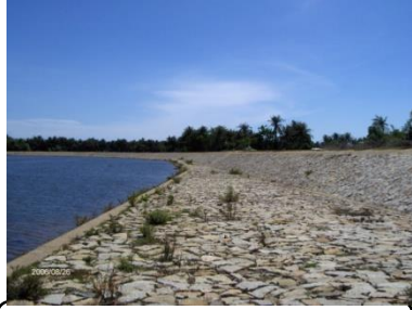
Công trình kè cửa sông thuộc huyện Phù Mỹ
