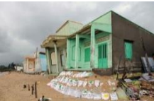
Sạt lở KV xã Vĩnh Tân, Tuy Phong
