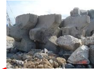
đê chắn sóng KV Nhà máy lọc dầu Dung Quất-Bình Sơn, QN
