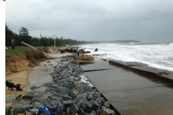
Kè chống sạt lở KV xã Tam Hải, Núi Thành
