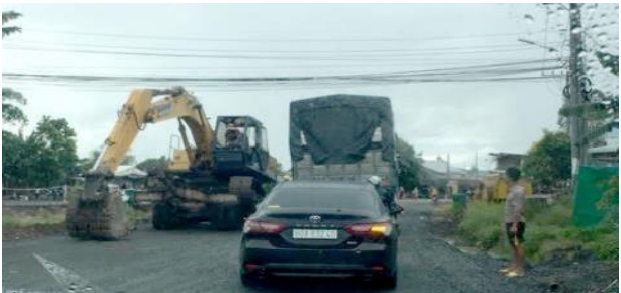
Hình 4. Một đầu nối tránh ngoài đang thi công
