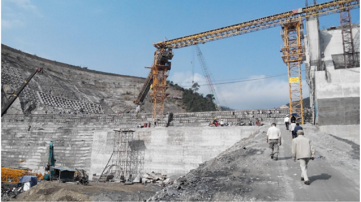
Đập bê tông đầm lăn
