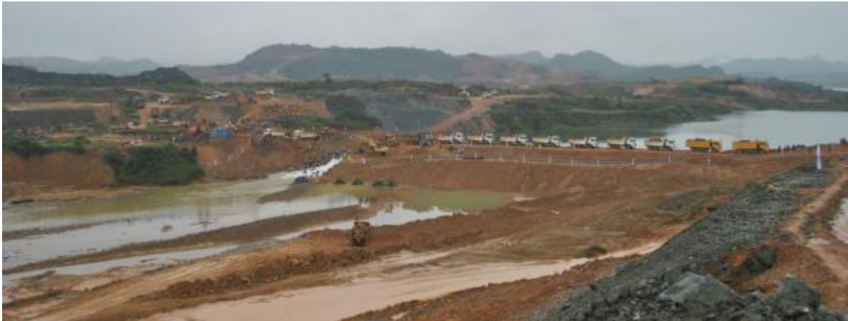
Từng đoàn xe chở đất, đá, khối bê tông nối đuôi nhau khẩn trương tới vị trí chặn dòng
