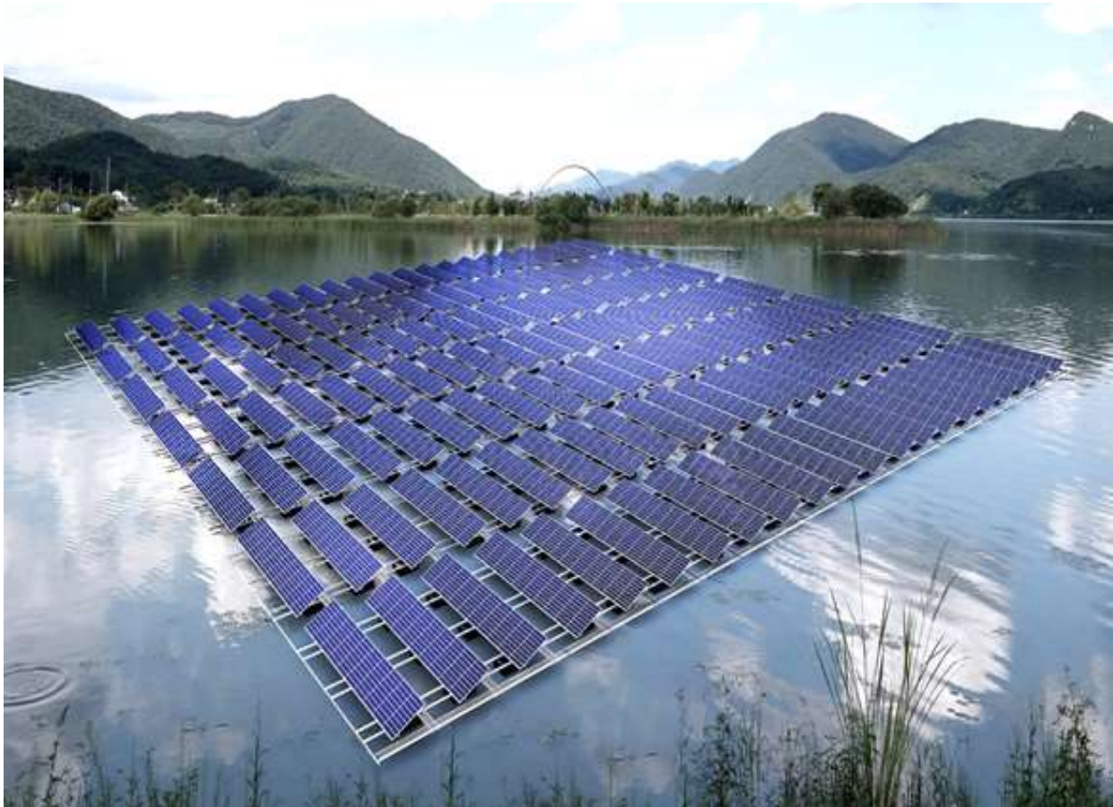
Điện mặt trời nổi tại hồ chứa
