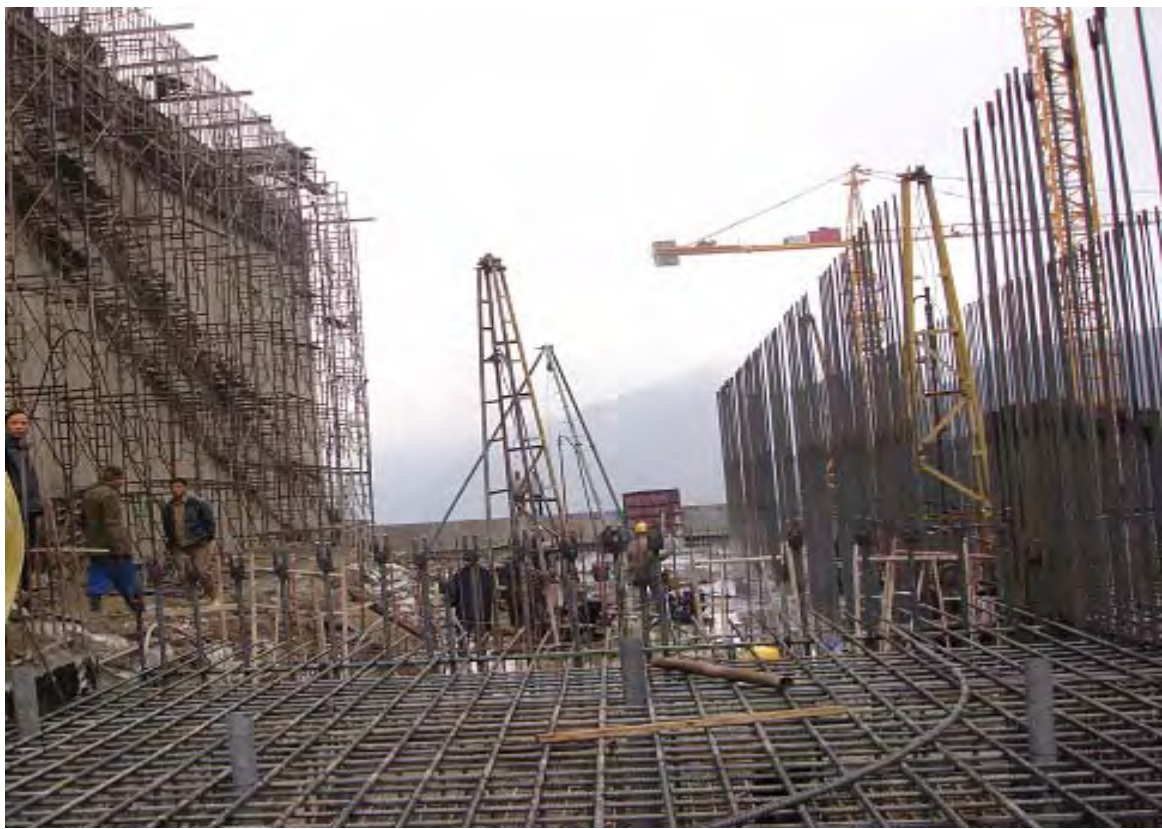
Thi công đập tràn bê tông cốt thép
