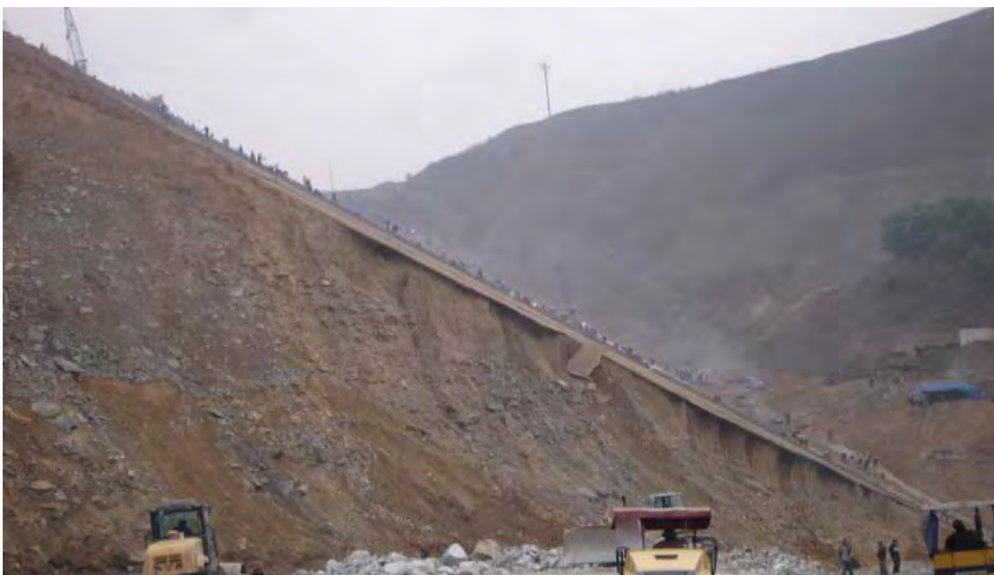
Nhìn lên mái thượng lưu phần đập bên vai phải
