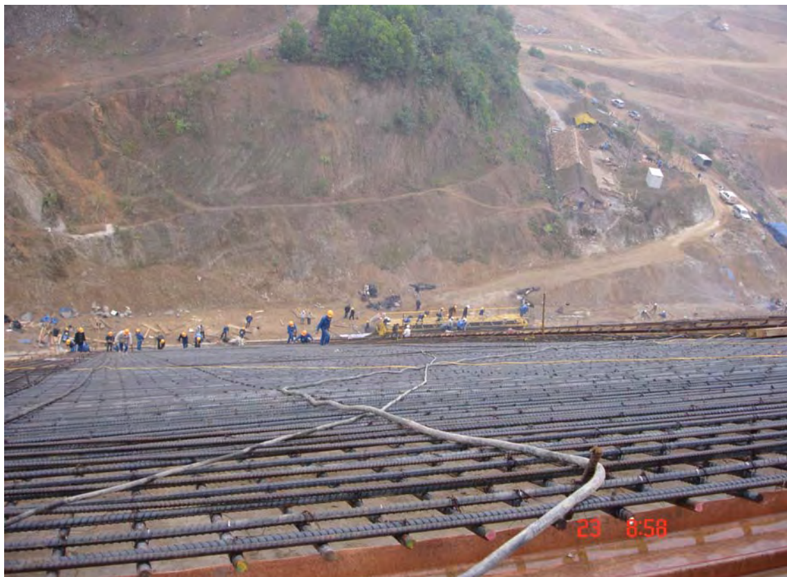
Đặt cốt thép chuẩn bị đổ bê tông bản mặt mái thượng lưu phía vai phải của đập
