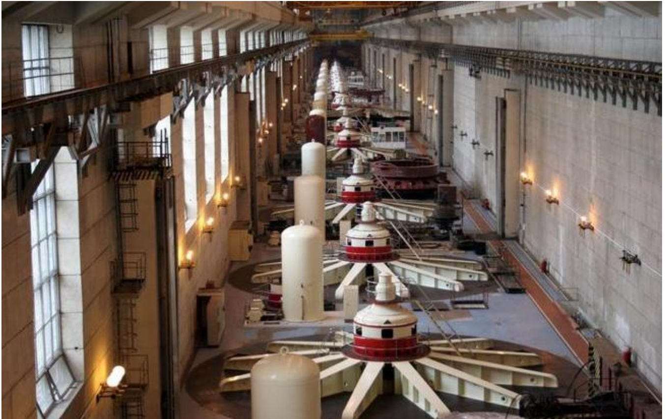
Đập tràn (ảnh trên) và gian đặt máy (ảnh dưới) tại thủy điện Zhigulevskaya.
