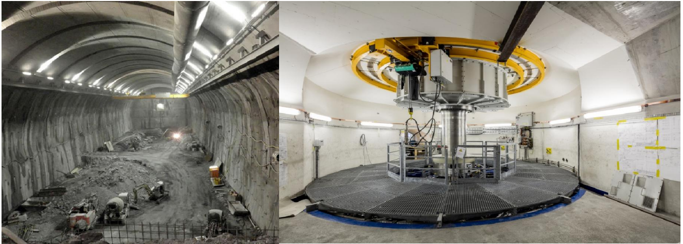
Gian hầm đặt máy lúc đang thi công (trái) và khi hoàn thành (phải).
