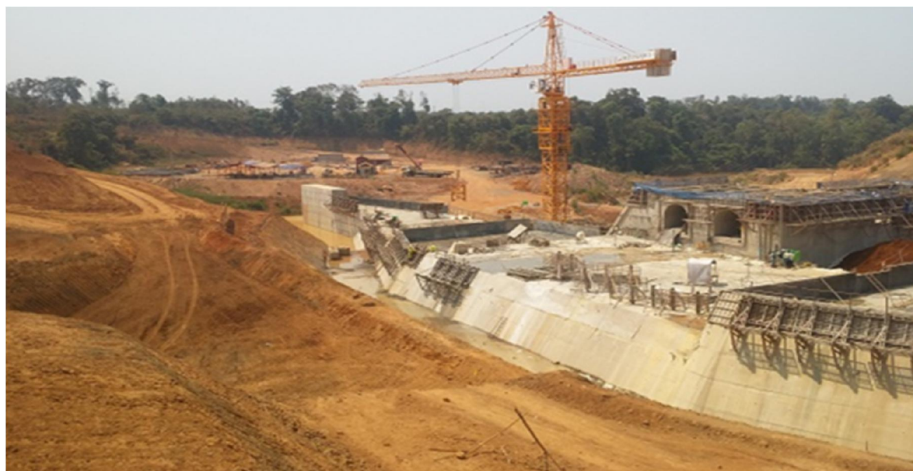
Thi công đập Xe Namnoy
