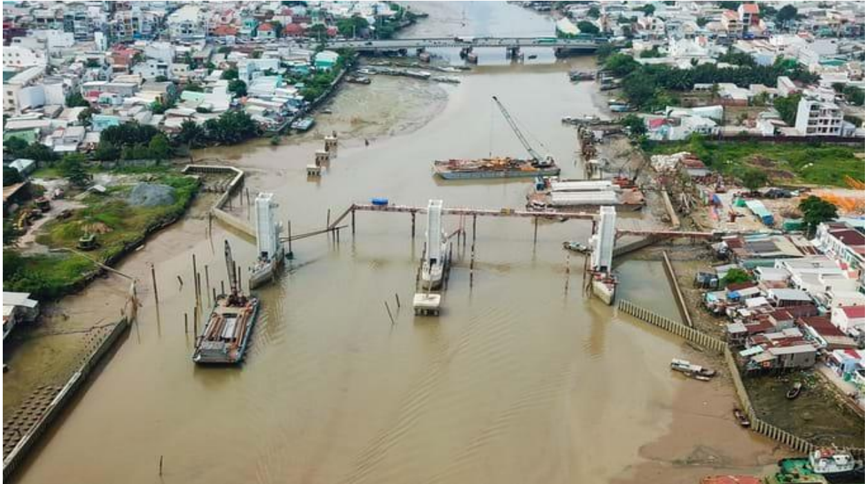
Cổng Phú Xuân (giữa quận 7 và huyện Nhà Bè) được xây dựng trên rạch Đĩa gần như hoàn thiện khung vây, ba tháp van, trụ pin...
