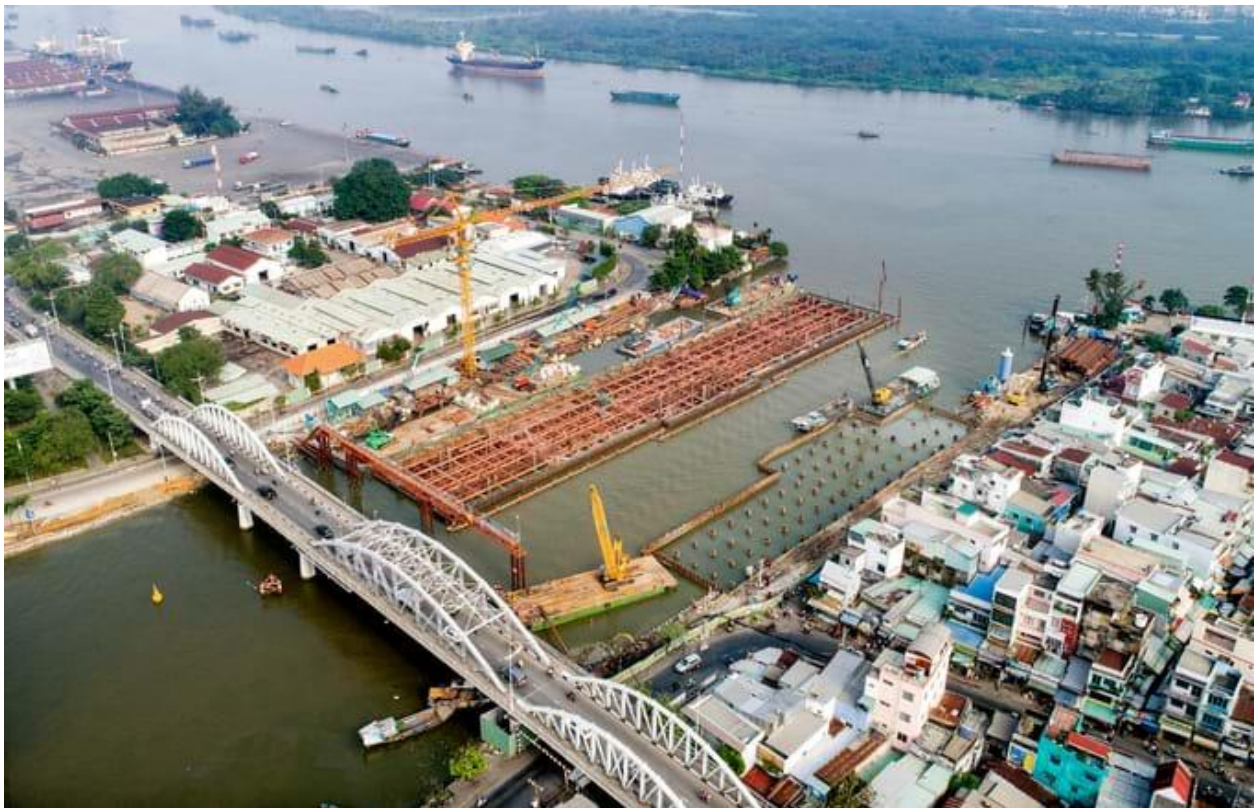
Cổng Tân Thuận (quận 7) cũng tạm ngưng khi đang thi công ép cừ, khung vây, bên cạnh là trạm bơm công suất 24 m 3 /s.
