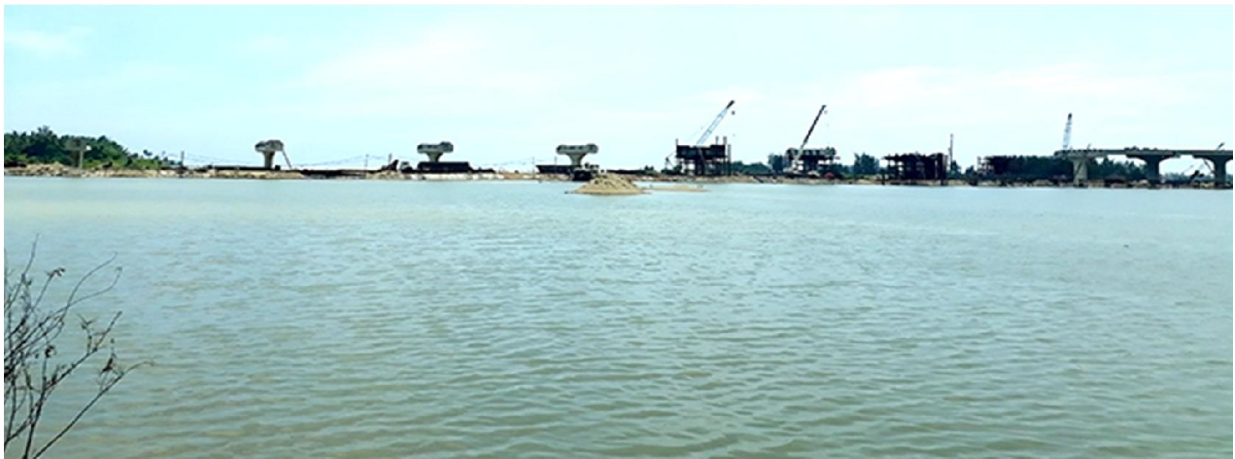
Dự án cầu Cửa Đại đang xây dựng cuối sông Trà Khúc
