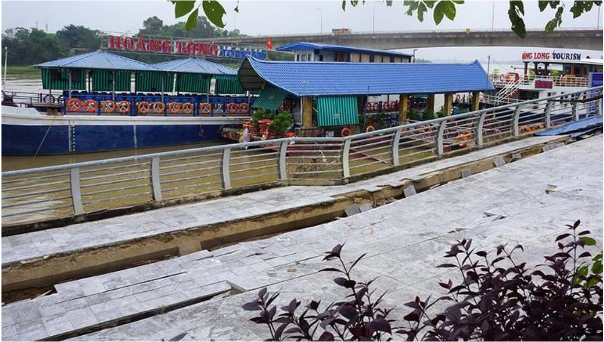
UBND tỉnh Thanh Hóa vừa có quyết định phê duyệt dự án điều chỉnh, sửa chữa công trình này với kinh phí hơn 34 tỉ đồng.
