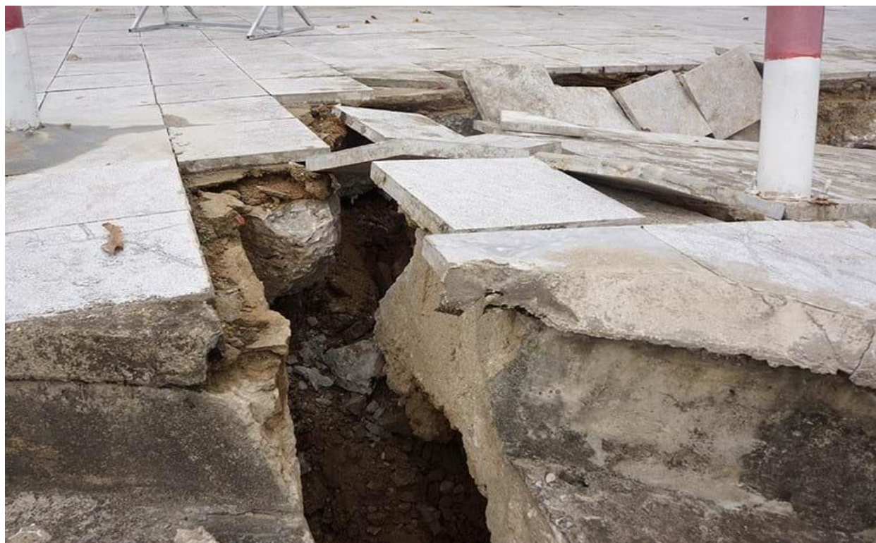
Chân kè là kết cấu bê tông cốt thép có độ dày 30cm, rộng m. Chân kè được gia cố bằng hai hàng cọc bê tông cốt thép, mái kè được lát bằng cấu kiện bê tông đúc sẵn, bên dưới là lớp đá dăm và vải địa kỹ thuật.
