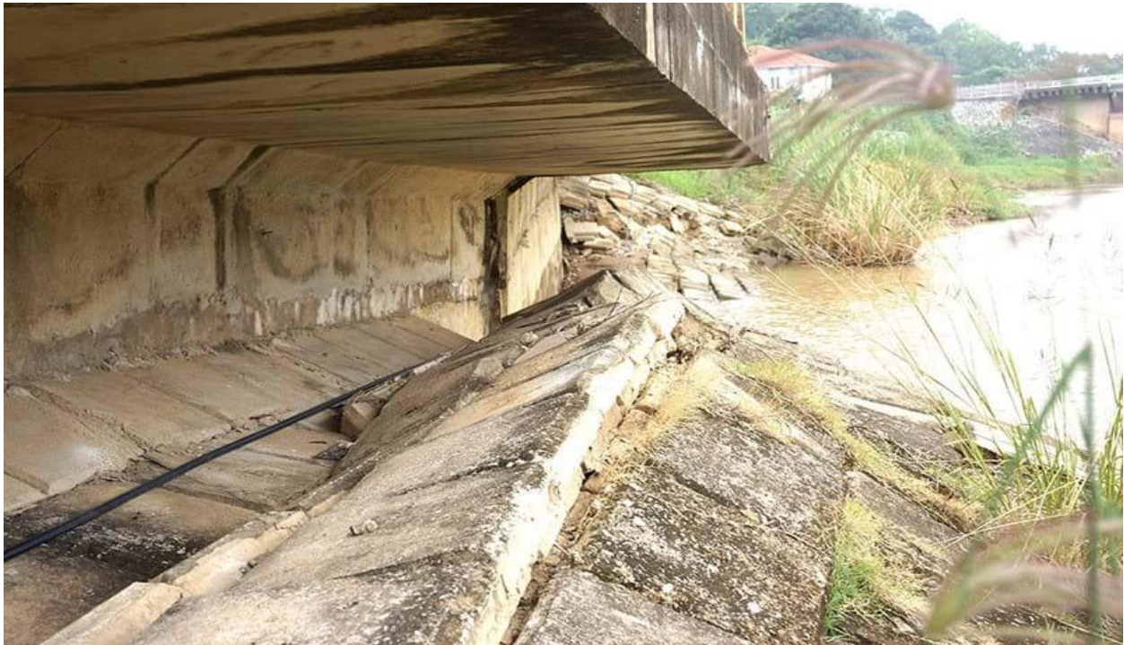
Phó Chi cục trưởng Đê điều và Phòng, chống lụt bão tỉnh Thanh Hóa Khương Anh Tuấn cho rằng lý do xuống cấp là do thay đổi dòng chảy, khu vực có hố xoáy nên đang khảo sát để xử lý.
