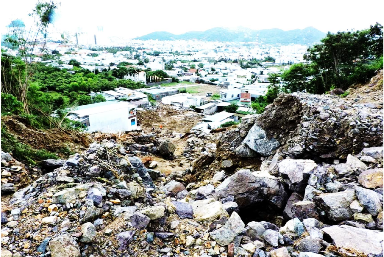
Hiện trường sự cố
