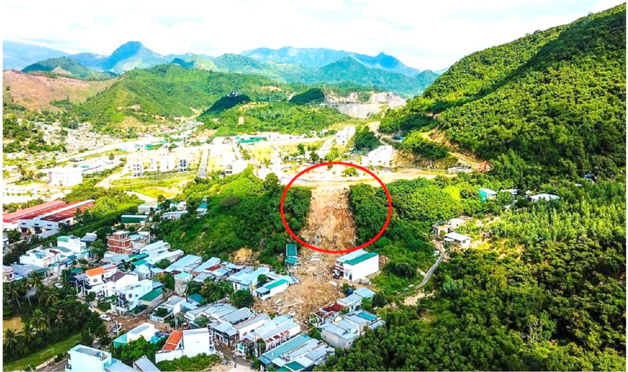
Toàn cảnh dự án khu dân cư Hoàng Phú (phường Vĩnh Hòa, TP Nha Trang, Khánh Hòa), nơi xảy ra lũ quét kèm theo lở núi khiến 4 người trong gia đình bị chết
