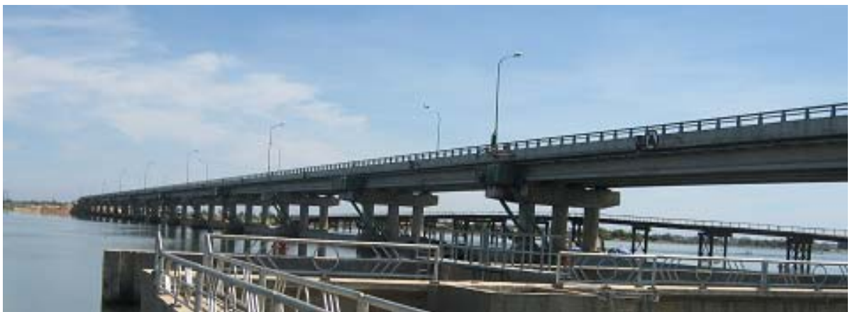
Cống đập Thảo Long (Thừa Thiên – Huế) dài hơn 500m trên hạ du sông Hương
