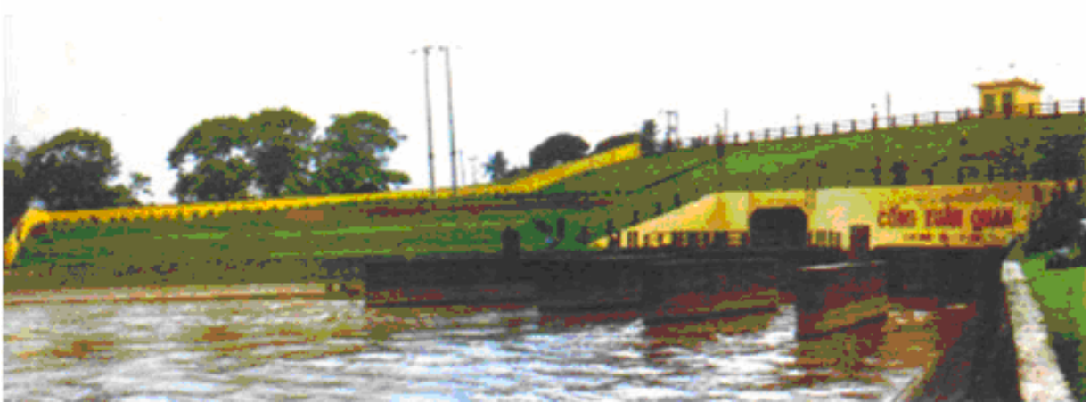
Cống Xuân Quan (Hưng Yên), công trình đầu mối nhận nước sông Hồng ở hệ thống thủy lợi Bắc-Hưng-Hải, được xây dựng trong những năm 1958-1960
