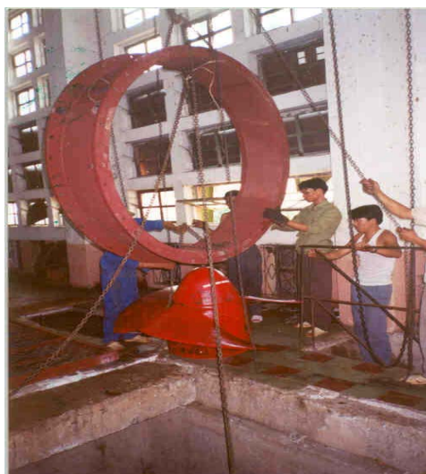
Hình 1. Bơm 36.000 m 3 /h
