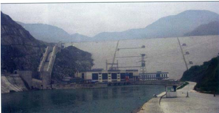
Đập đá đắp bản mặt Tử Bình Bạc (Zipingpu) bê tông cao 156 m, cách tâm chấn động đất 17 km.
