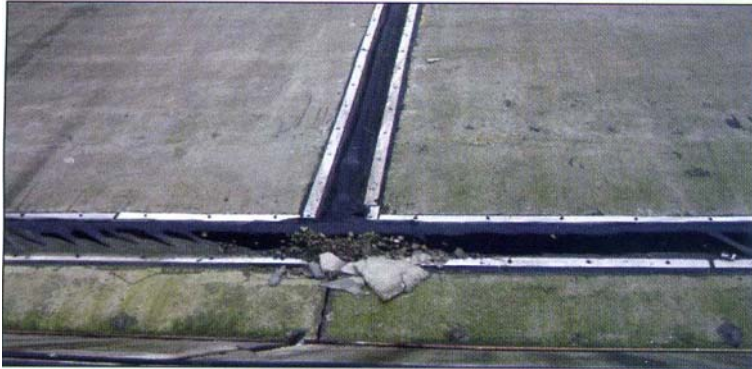
Hệ thống ngăn nước mặt không bị phá hỏng ở đập Từ Bình Bạc (Zipingpu)
