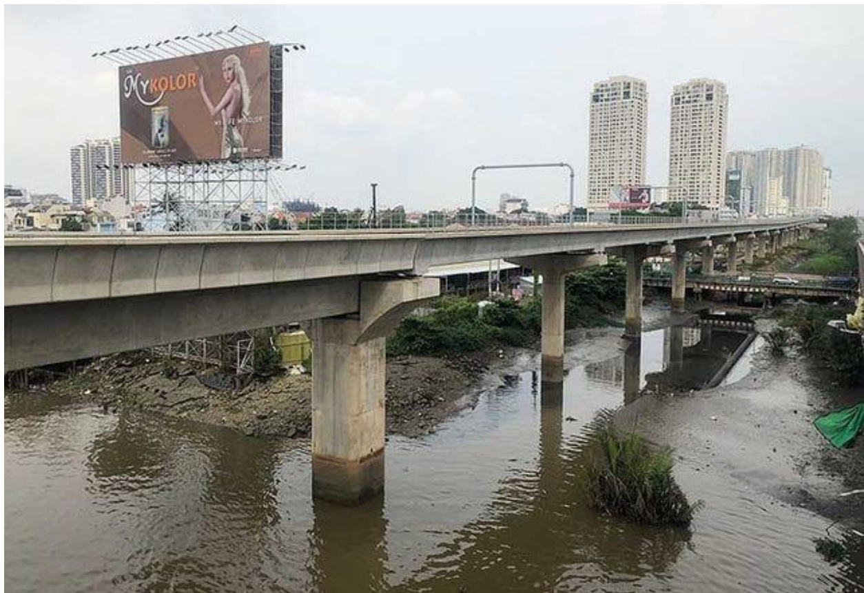
Dự án đường sắt đô thị metro Bến Thành - Suối Tiên đang chậm tiến độ, đội vốn.
