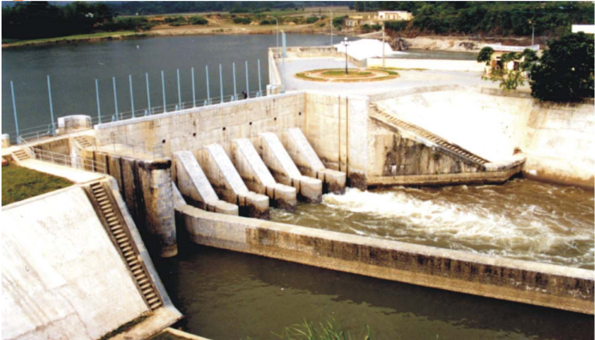
Công trình đầu mối Bái Thượng (hệ thống thủy lợi Sông Chu, Thanh Hoá)
