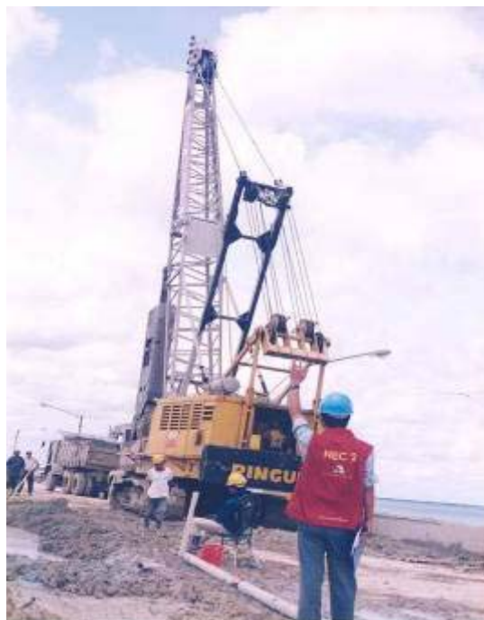
Thi công tường hào betonite chống thấm tại đập chính Easup Thượng
