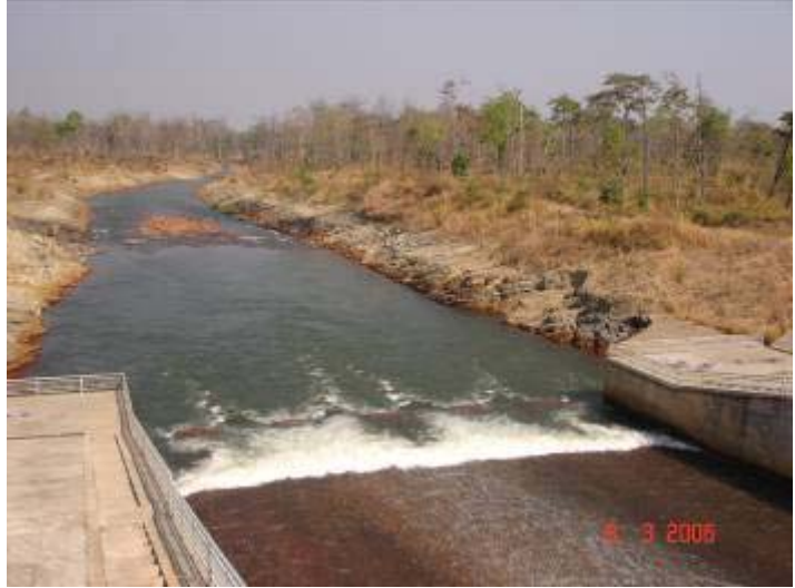
Nước qua đập tràn hồ Easup Thượng (Đăk Lăk)
