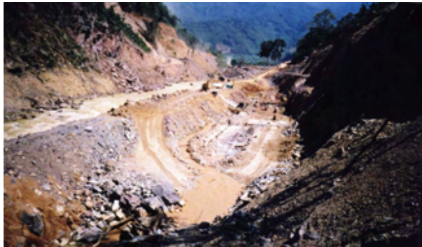
Hình ảnh dẫn dòng giai đoạn I thi công đập chính Thủy điện A Vương
