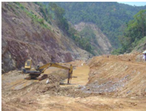
Hình ảnh xử lý nền móng công trình Thủy điện A Vương - Quảng Nam
