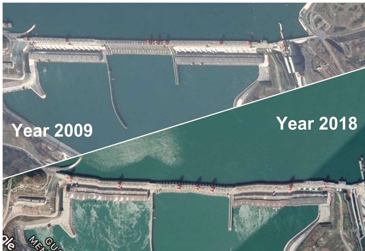
Des faiblesses structurelles révélées par Google Earth sur l'immense barrage des Trois Gorges en Chine (Epoch Times)
