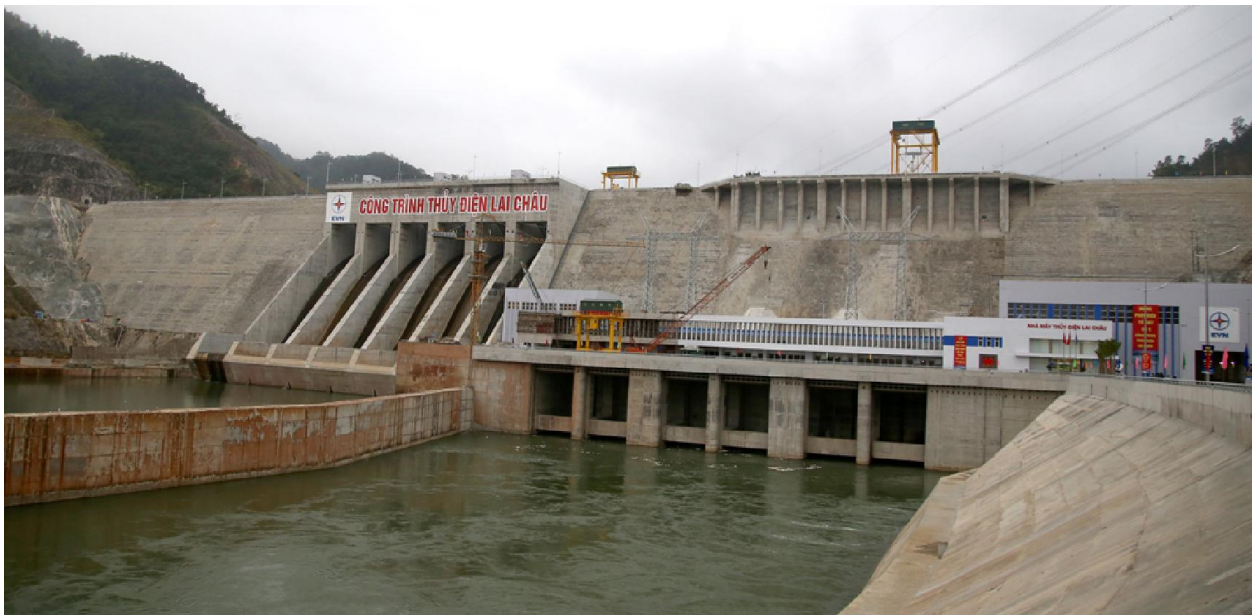
Đập đã được thi công xong, tuabin đầu tiên đã phát điện
