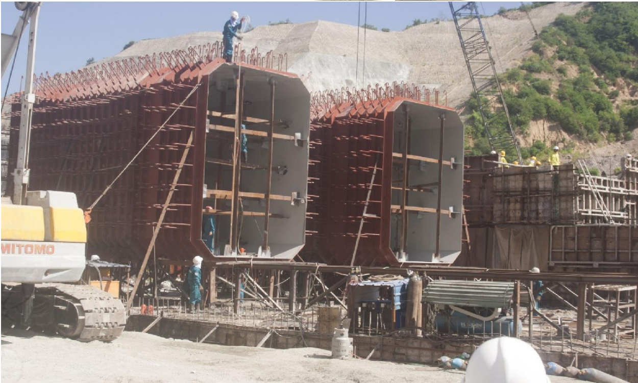
Công trường xây dựng đập
