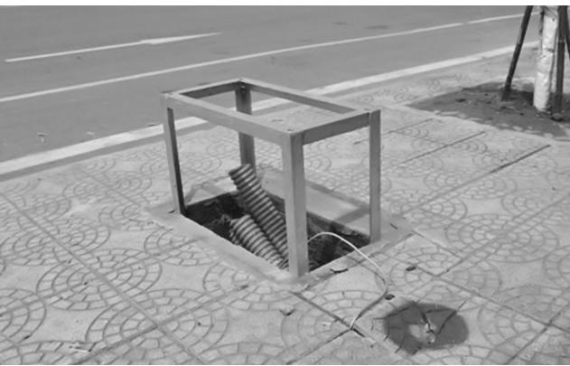
Khi dưới nền đường không có tuy nен và hào kỹ thuật thì không gian ngầm dưới hè phố là nơi chứa đựng nhiều hạ tầng theo tuyến như đường điện, đường cáp quang, đường ống cấp nước, cống thoát nước, để việc lắp đặt và sửa chữa ít ảnh hưởng đến giao thông đô thị. Cơ quan quản lý hè đường cần có bản đồ (số hóa) đầy đủ về hệ thống ngầm đó để phục vụ việc cho phép đào bới hè đường khi cần thiết.
