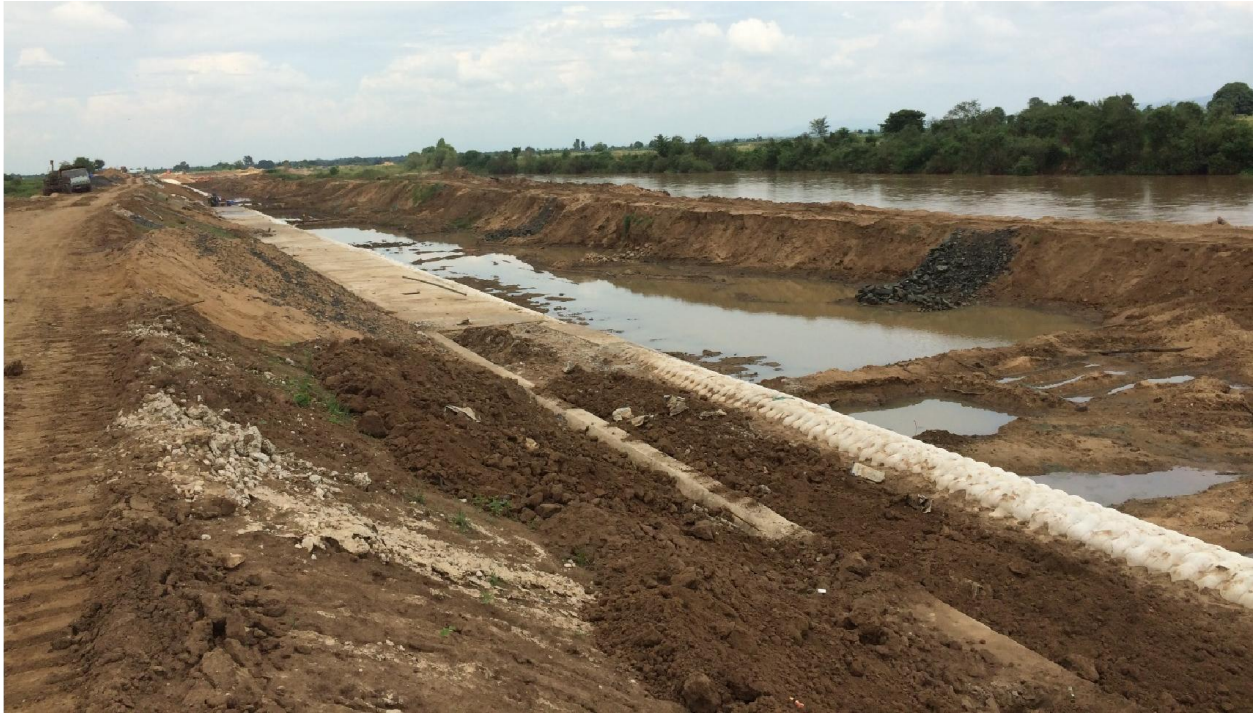
Hiện trường thi công
