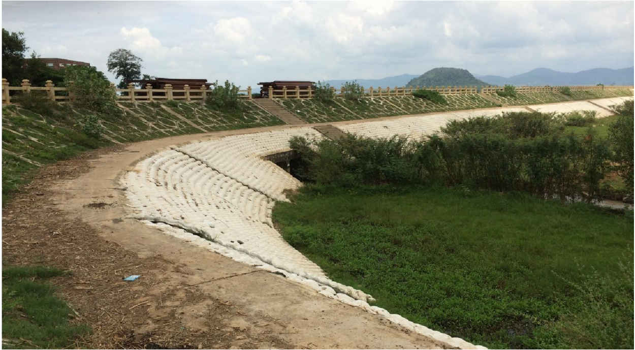
Đoạn kè đã hoàn thành
