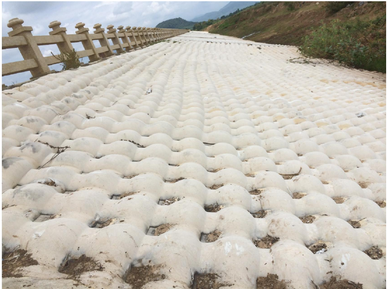
Mái kê vữa xi măng trong túi khuôn
