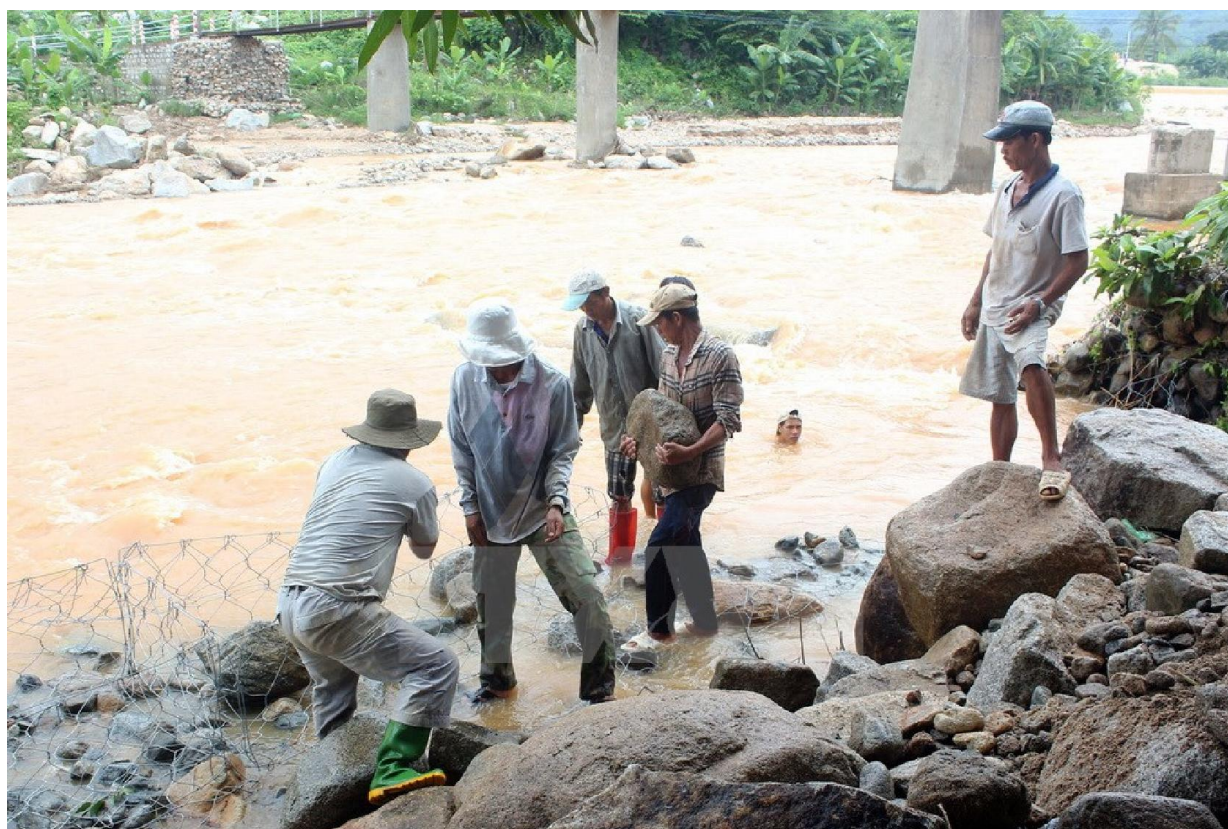
Lực lượng chức năng huyện Ninh Sơn tập trung gia cố đê bao Sông Dinh bị xói lở. (Ảnh: Công Thư/TTXVN)
