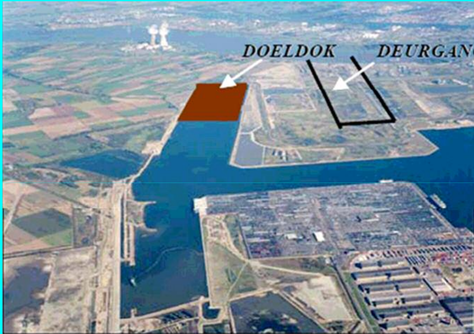
Khu vực xây dựng đập
