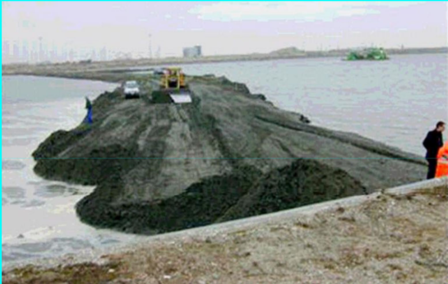
Thi công đập tại cao trình +4,5
