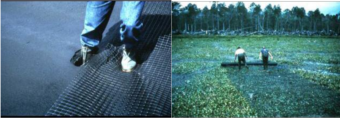
Hình 7: Gia cố nền để đi qua vùng đầm lầy, lún sụt
