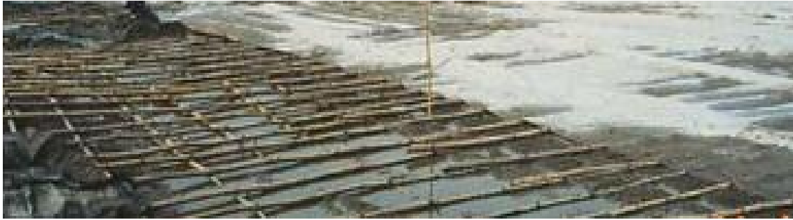
Hình 4: Sử dụng phân tre gia cố nền đất yếu
