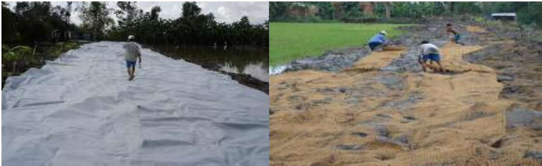
Hình 5: Trải vải địa kỹ thuật và thảm xơ dừa làm cốt và nền đê ở ĐBSCL
