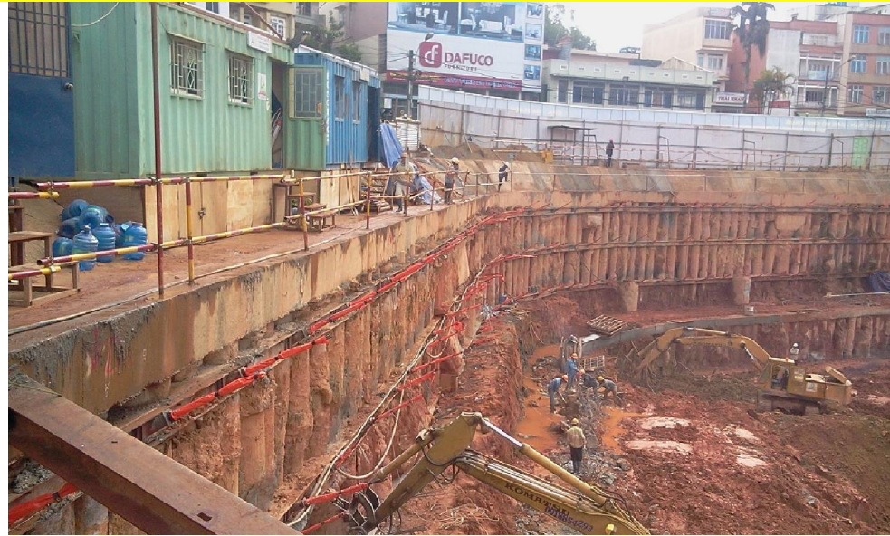
Hồ móng sâu 20m cho 4 tầng hầm
