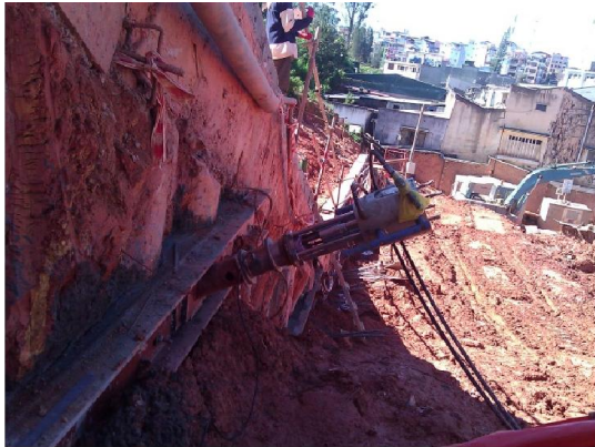
Quan trắc lực trong neo ứng suất trước bằng Loadcell
