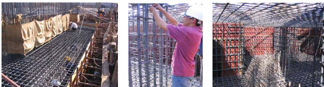
Hình 5,6,7 : Lắp đặt thiết bị kiểm tra tại móng M3 công trình CANTAVIL Q2 TP.HCM
