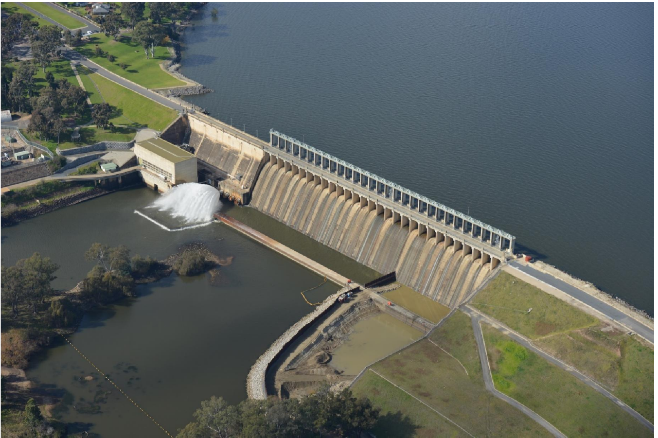
Đập đa mục tiêu Hume trên sông Murray, bê tông trọng lực, cao 51m, chiều dài tại đỉnh 1615m, công suất điện 58MW, tạo hồ chứa hơn 3 tỷ m 3 nước, xây dựng xong năm 1936.
